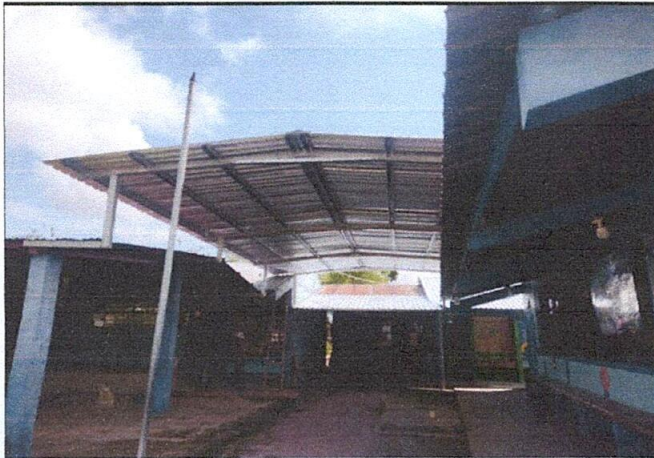
Foto 1: MEJORAMIENTO DE ESTRUCTURA TECHO TIPO PORTICO
